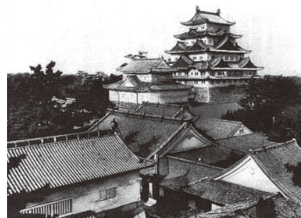
▲消失前の天守閣。層塔型で5重5階、地下1階、高さは55.6m（天守台19.5m、建屋36.1m）と、18階建ての高層建築に相当する規模。
