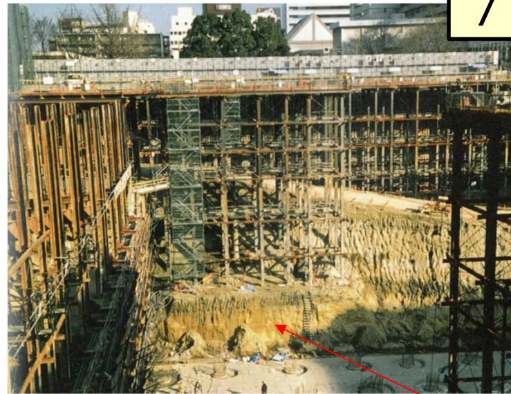
愛知芸術文化センターの工事現場に露出した 熱田層
